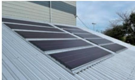
老朽化した屋根の上に新しい屋根を重ね葺きするWKカバー工法に合わせた、軽量の太陽光発電システムを開発しました。「岐阜技術センター」では、様々なメーカーの太陽光パネルをより軽量に設置できるように施工方法の開発を進めています。
